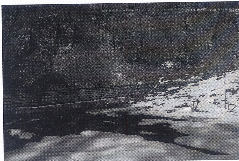
Харамията – възстановяване на каменна облицовка, почистване
