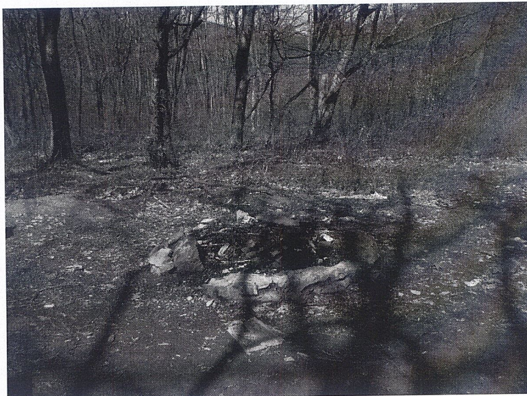
Огнище (предвижда се почистване и възстановяване на каменната зидария)
